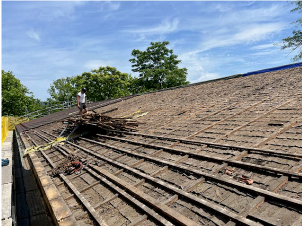
KIR, Rückbau, Schindelunterdach
