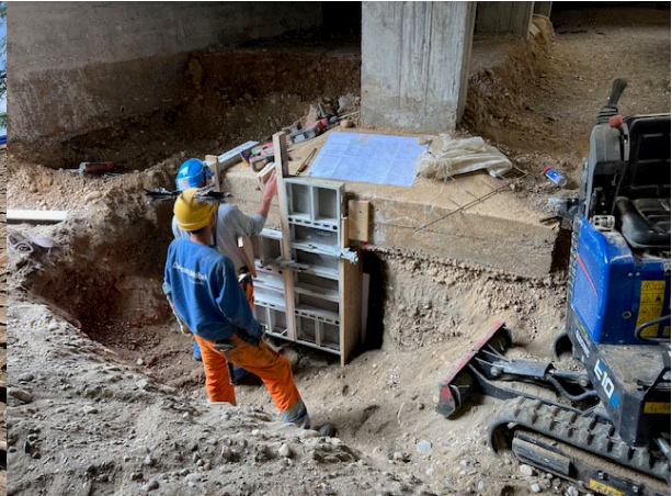
KIR, Unterfangung Stützen
