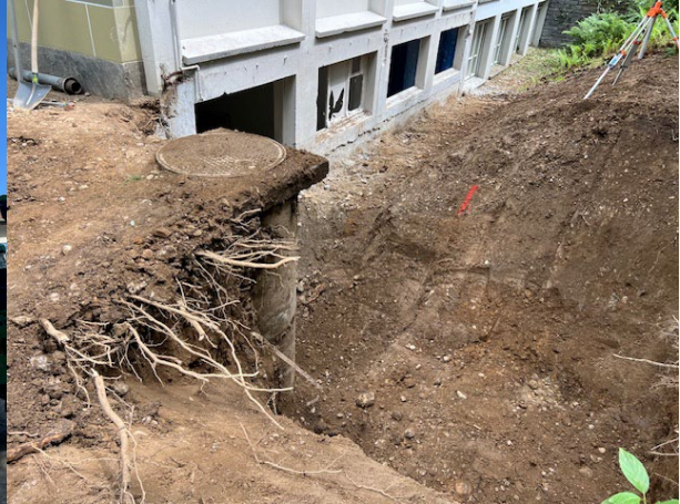
QH, Ostfassade, Abgrabung neue Fenster
