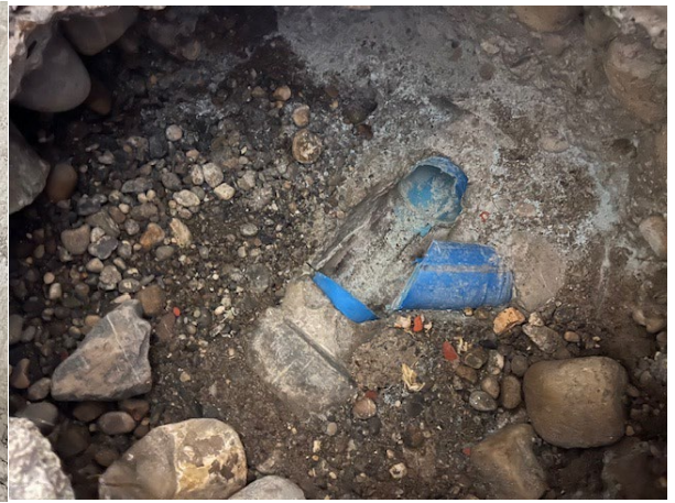
QH, Kan. sanierung, Freilegung Abzweigung
