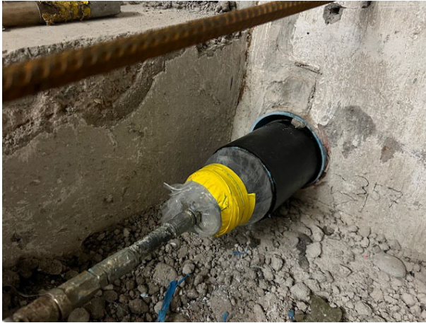
QH, Kan. sanierung, Übergang Alt - Neu
