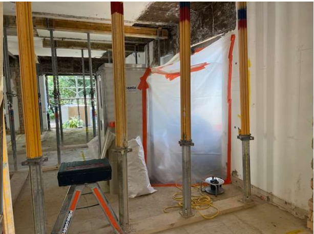
QH, EG, Schadstoffsanierung PAK
