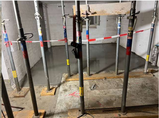
QH, UG, Bodenplatte Waschküche
