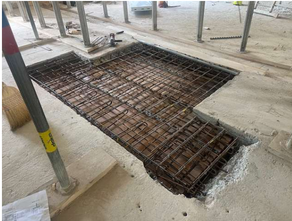
QH, Decke ü. EG Bereich Kaminabbruch
