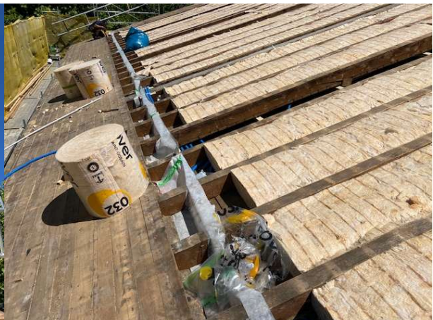
KIR, Dach, neuer Dachaubau
