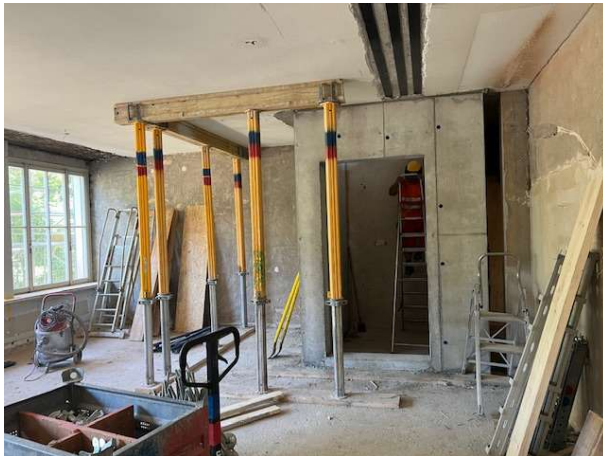
QH, EG, Liftschacht
