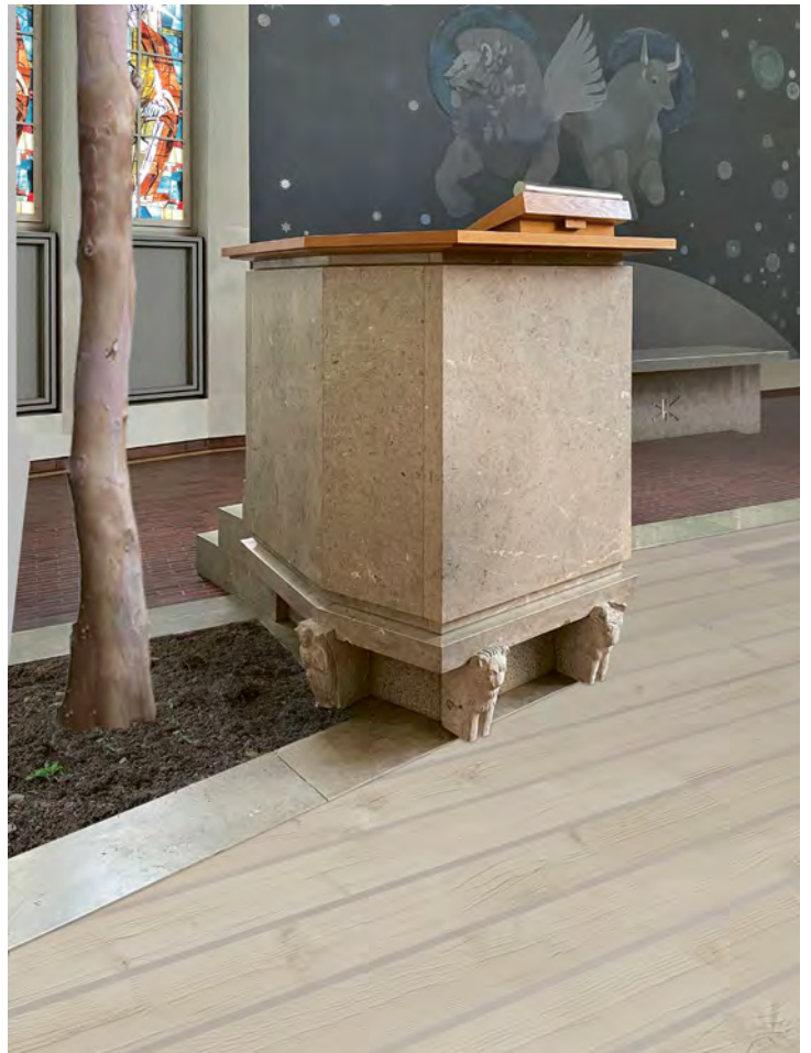
Die neue Bodenebene umfließt den Kanzelfuss, die Pflanzgrube wird reaktiviert.
